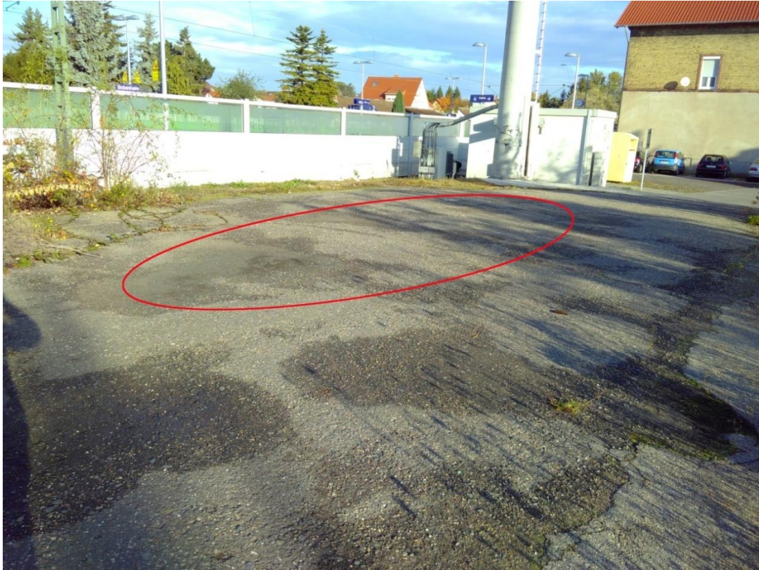
Foto 4: Ausweichplatz für ca. 2 – 3 Autoparkplätze
