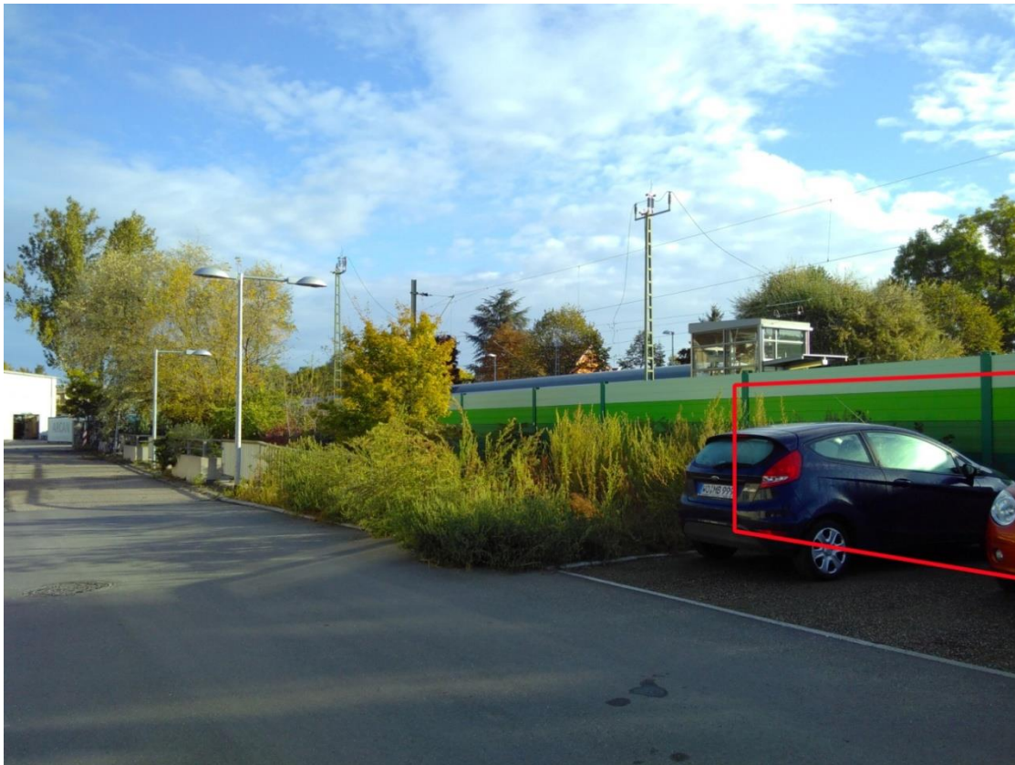
Foto 5: vorgeschlagener Standort an der Westseite, Richtung Kleinniedesheim
